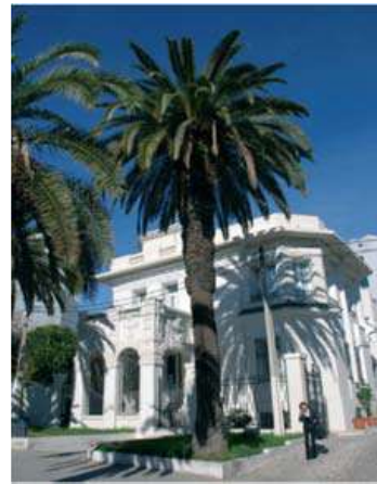
Figure 2 : Vue du siège de l'ordre des experts-comptables après intervention
