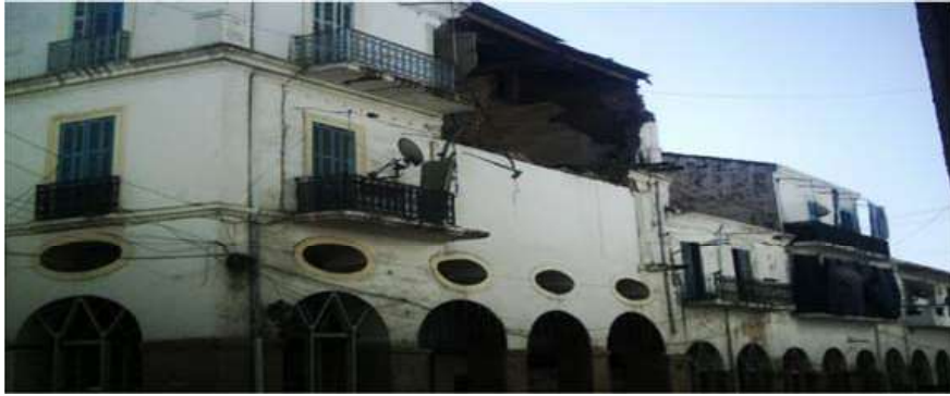
Photo 2 : Des habitations en danger CTC Skikda/2012 Auteur 2018
