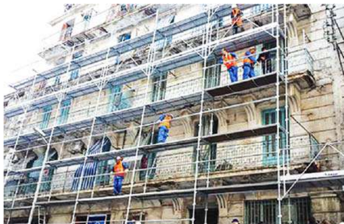
Photo 3 : Lancement des travaux de réhabilitation, Immeuble test Auteur 2018
