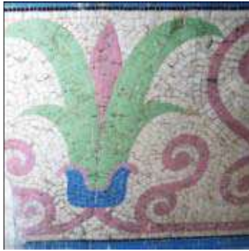
صورة 16: زخرفة بهو دخول مبنى 12 شارع لندرا
