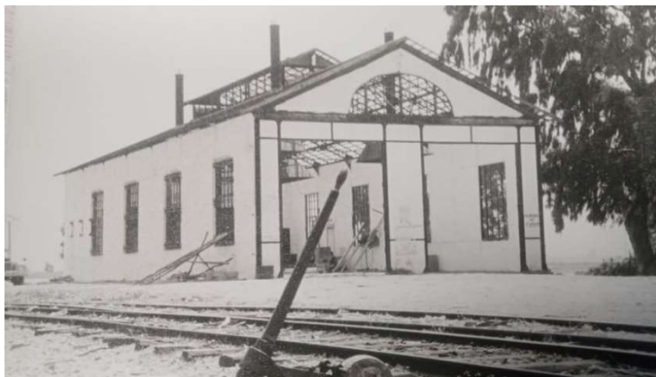
Figure 6 : Le hangar, ancien atelier de réparation des locomotives de trains, et lieu de spectacles. Source : fond photographique Hanafi Ben Cherif (photo Quinneville), Mars 2022. Inédite
